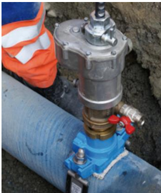
Anbohrgerät aufsetzen Beispiel: Anbohrgerät mit automatischem Vorschub
