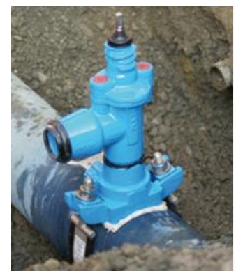
Absperrarmatur montieren, kontrollieren, ob Schieber geschlossen ist und Absperrblech demontieren
