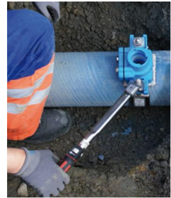
Anbohrschelle mit der Dichtung montieren, Dichtmasse ausgleichen und glattstreichen, Schrauben des Haltebügels gemäss Anzugsdrehmoment anziehen
