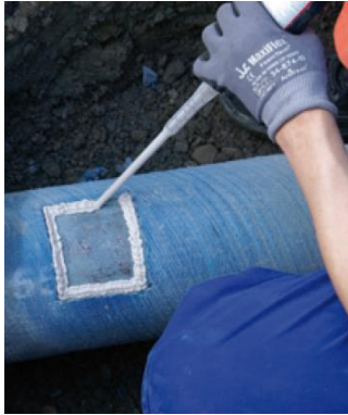
Dichtmasse entlang der Schnittstelle auftragen. Die Nachisolierung kann auch nachträglich erstellt werden
