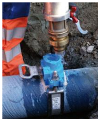
Anbohrgerät demontieren
