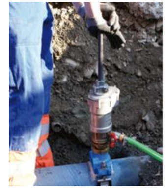
Bohrspindel kontrolliert zurückziehen
