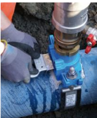
Anbohrschelle mit Steckblech schliessen
