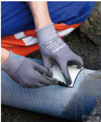
Ausschnittfenster mit Hilfe einer Schablone anzeichnen bei Rohr mit Zementbeschichtung, z.B. FZM, ZMU etc.
