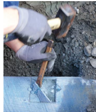
Zementbeschichtung entfernen und Dichtfläche reinigen
