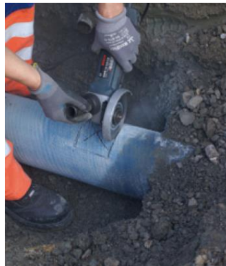
Zementbeschichtung anschneiden Achtung: Kernrohr nicht verletzen
