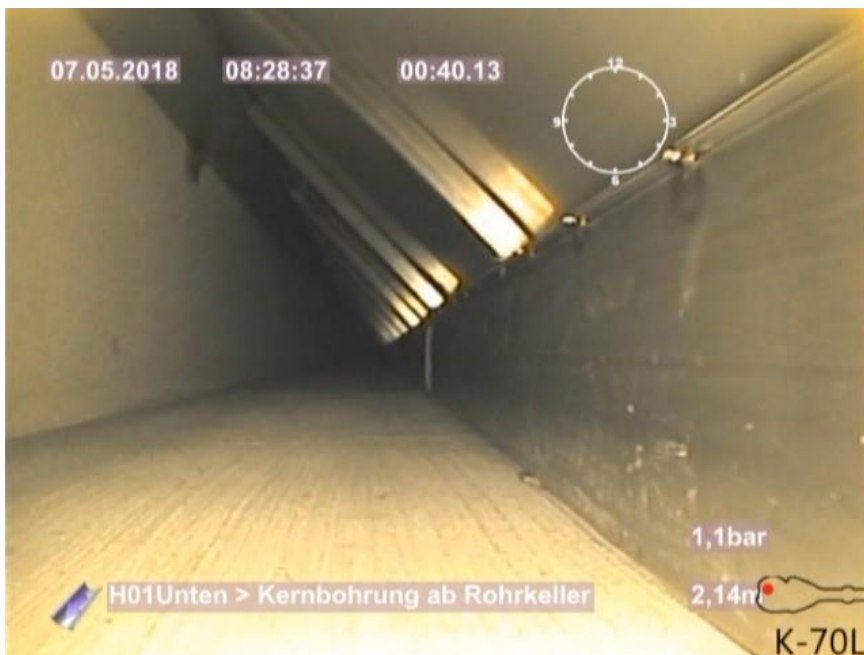
Kamerabefahrung Inspektionskorridor Wand-Boden
