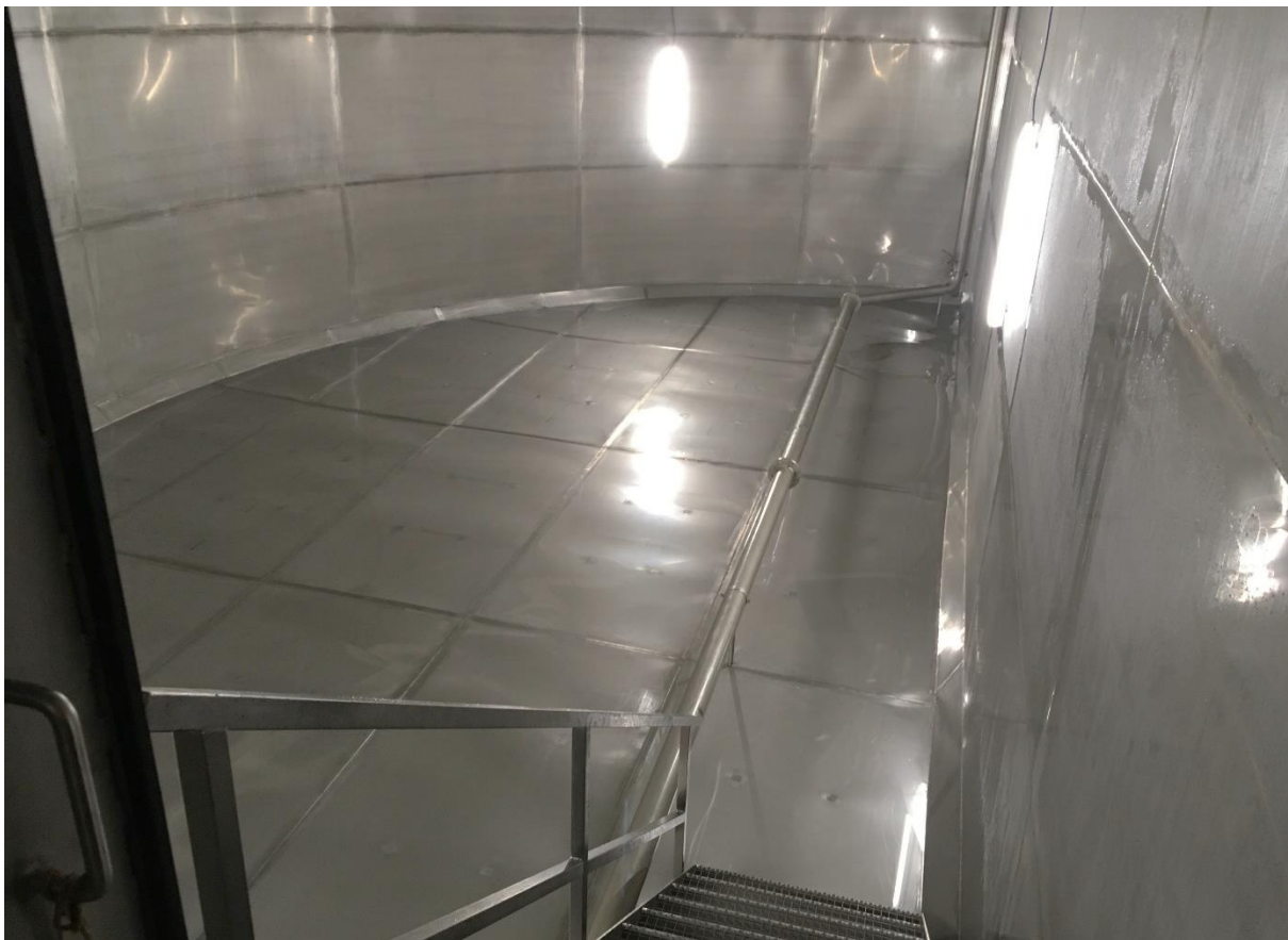
Reservoirkammer mit neuer Edelstahlauskleidung
