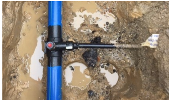
Sichtprüfung Hausanschluss
