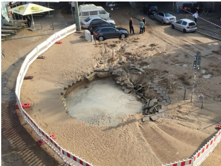
Schadensbild einer defekten Wasserleitung
