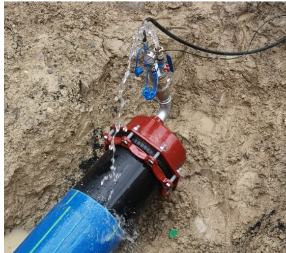
Verfahrensübersicht Druckprüfung
