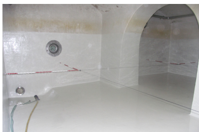
Horizontal-Anode nach dem Einbau
