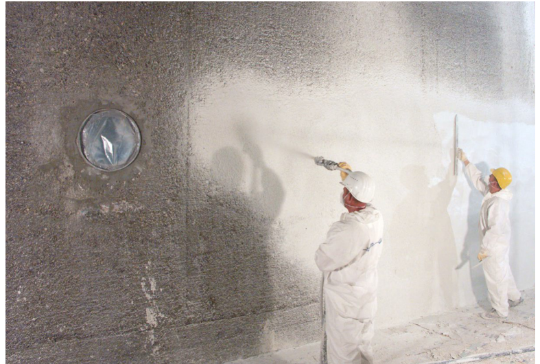
Sanierungsarbeiten Reservoir Froloo
