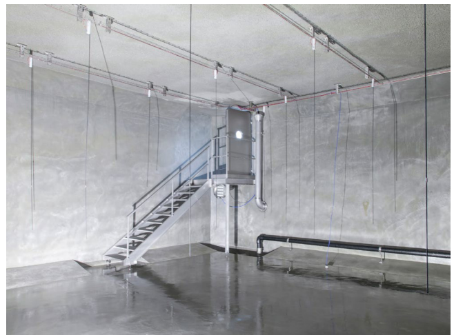
Reservoir Hollen in Ettingen, BL: Neuer Eingangsbereich mit Drucktüre, Treppe etc.
