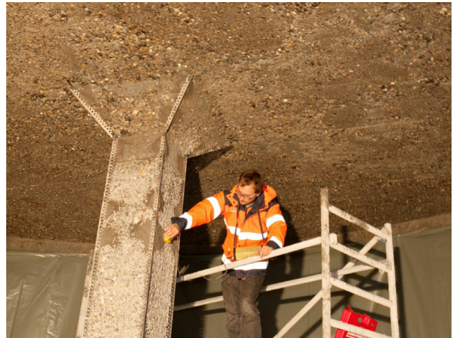
Reservoir Rebberg in Reinach BL: Prüfung an der vorbereiteten Oberfläche
