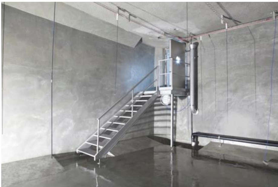
6) Sanierte Kammer vor der Inbetriebnahme.
