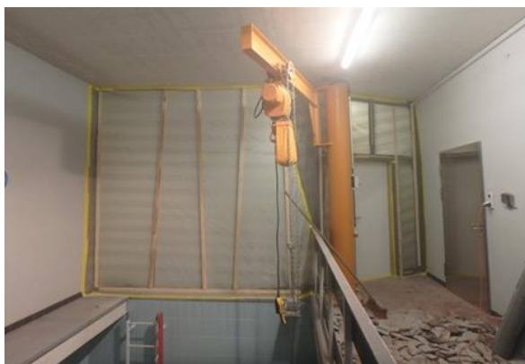
1) luft- und staubdichte Abtrennung
