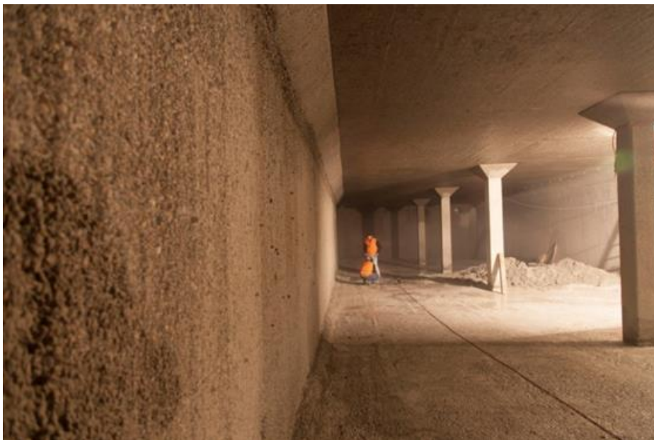
5) Vorbereitete Betonoberflächen, bereit zur Abnahme/Prüfung
