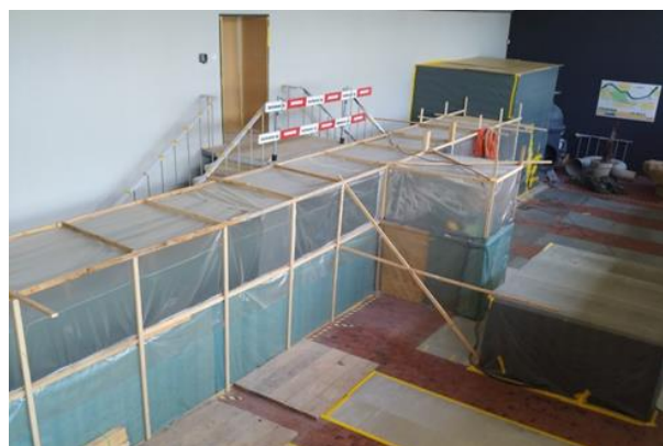
2) Einhausung vom Eingang bis Kammerzugang
