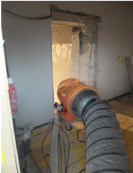
3) Drucktüröffnung mit Lüftung
