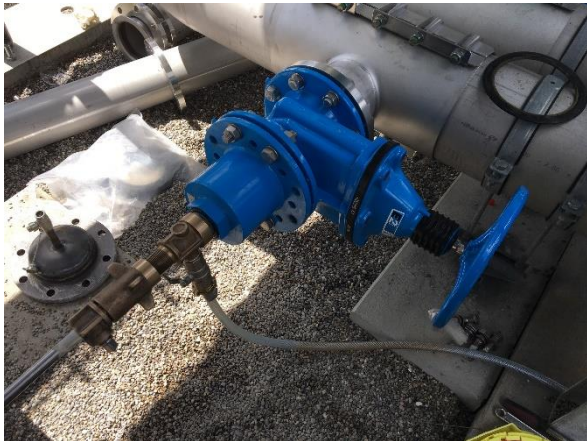
Anbohrung V2A-Rohr DN 250 mit Bohrer 126 mm
