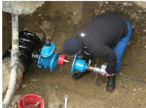
Anbohrung AZ-Rohr DN 350 mit Bohrer 146 mm
