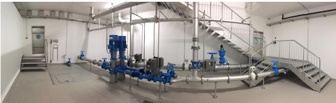
Abb. 6: Rohrkeller im Ersatzneubau
