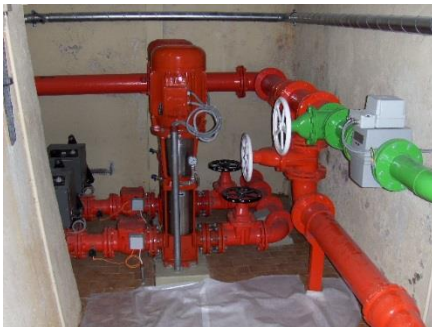
Abb. 4: Rohrkeller im alten Reservoir
