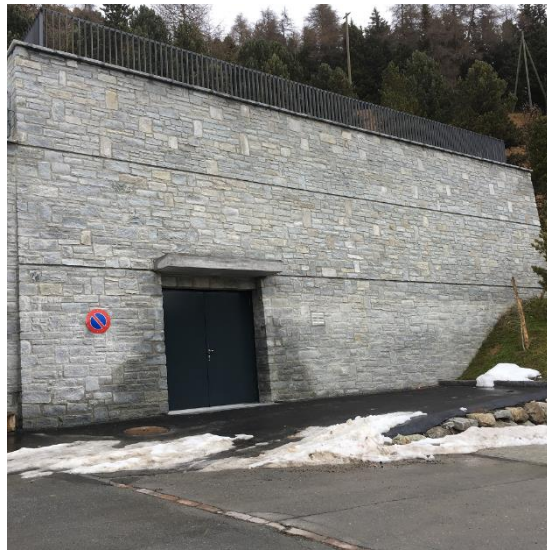
Abb. 5: Neues Reservoir mit einem Eingang
