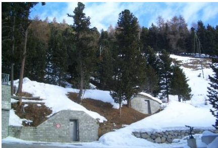
Abb. 3: Altes Reservoir mit zwei Eingängen
