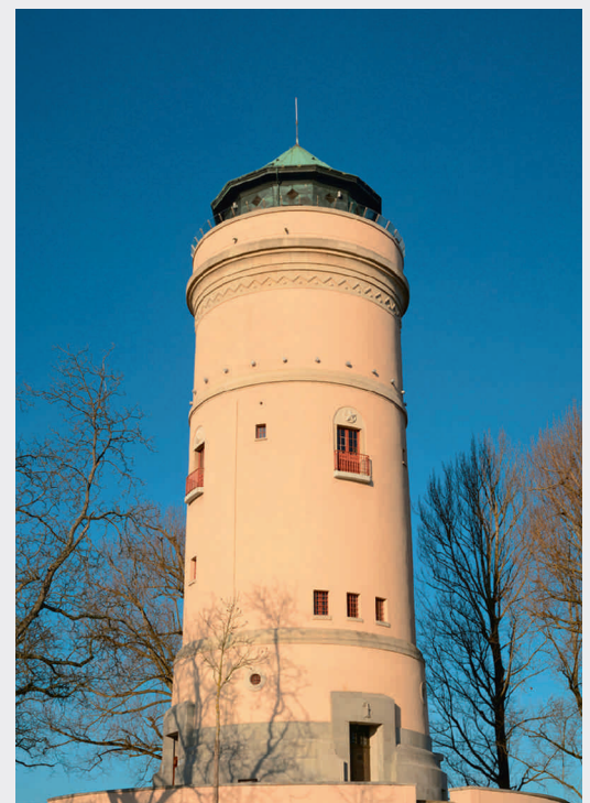
Fig. 2 Wasserturm Château d'eau (Foto: W. Sojka)
