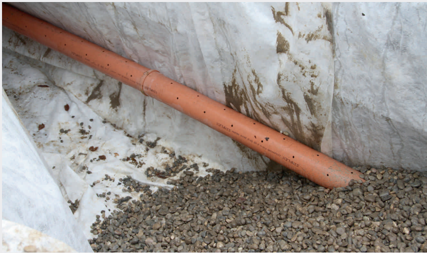
Fig. 10 Eine Drainageleitung, eingebettet in einer Kiesschicht, soll künftig das Hangwasser vom Reservoir fernhalten Canalisation de drainage insérée dans une couche de graviers pour tenir les eaux de ruissellement éloignées du réservoir
