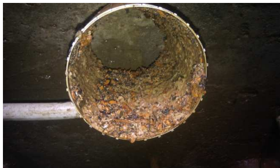
Verschmutzung eines Schmutzfängers
