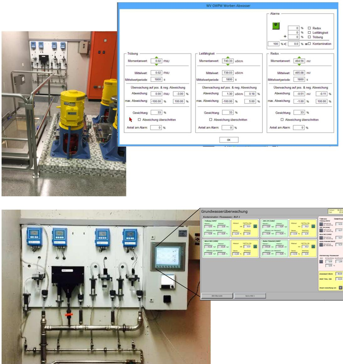
Abbildung 6-2: Unabhängig vom Messgerätehersteller können die Signale der Online Messparameter in die uni-logIQ® Bausteine eingelesen und ausgewertet werden.
