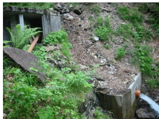
Brunnenstube vor Baubeginn
