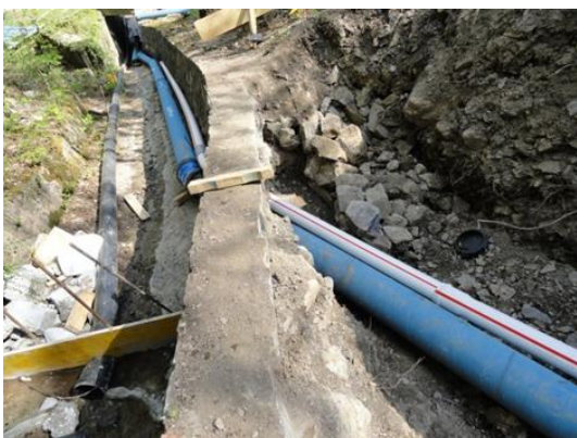
Leitungsverlegung Bachgerinne neben der Bauerstrasse
