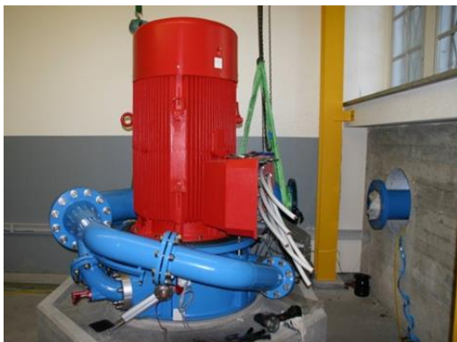
Montage Turbine und Generator
