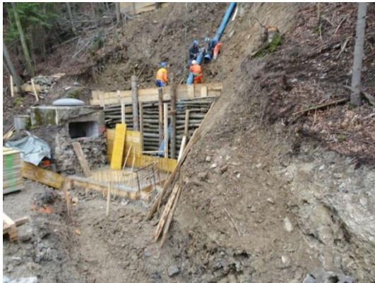
Bodenplatte Armaturenschacht neben Druckbrecher 2
