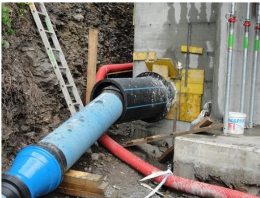
Druckleitungsanschluss ans Ausgleichsbecken
