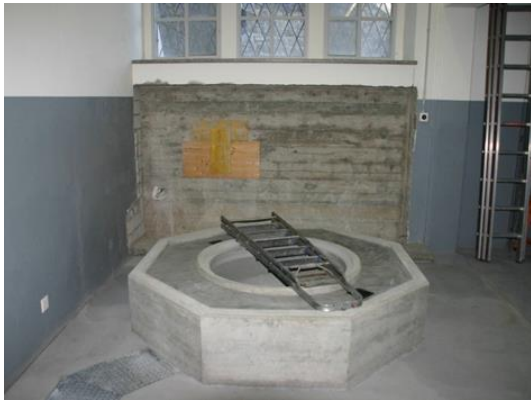
Achteckiger Unterbau zur Turbinenlagerung
