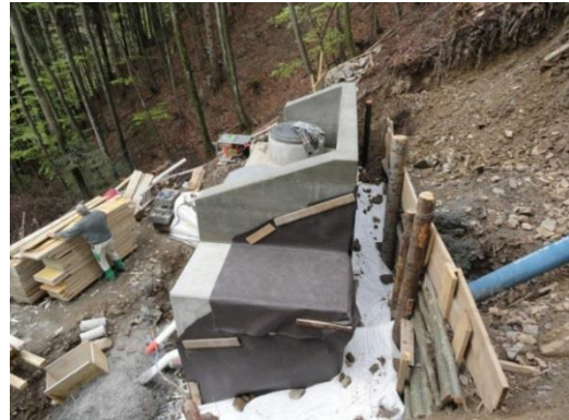
Sickerpackung und Schutzmassnahmen Einstieg
