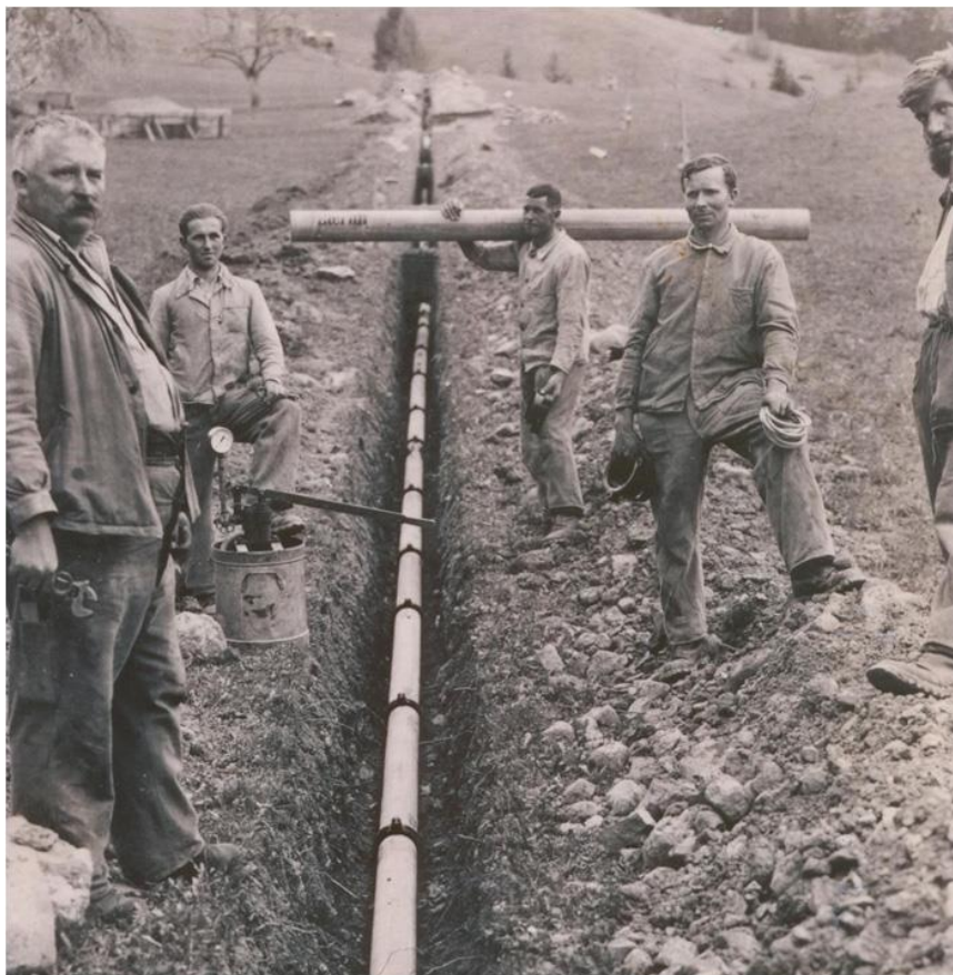
Construction d'une conduite d'adduction pour la distribution d'eau de Sachseln, 1939
