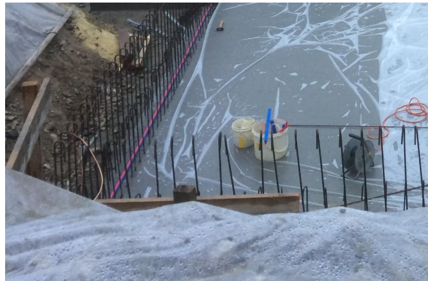
Étancher les joints, couvrir le béton
