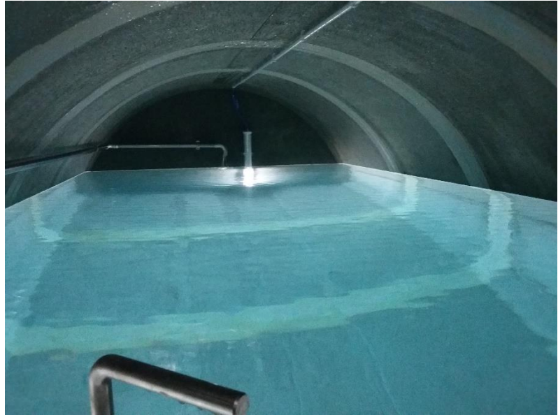
Réservoir en éléments préfabriqués
