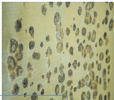
Corrosion galvanique sur un matériau inorganique non métallique
