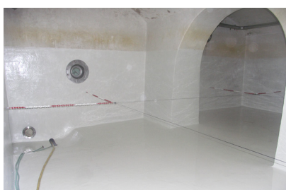
Protection cathodique contre la corrosion installée dans un réservoir remis en état
