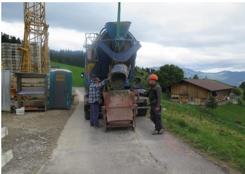
Frischbeton, Qualitätskontrolle auf Baustelle
