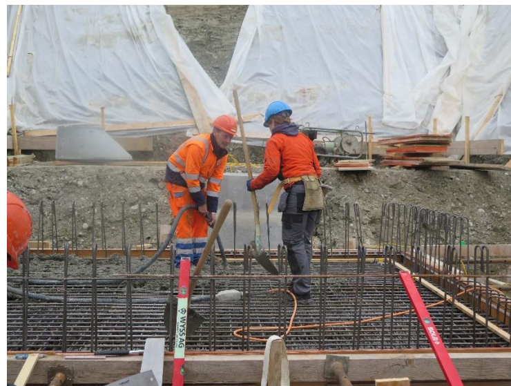
Richtig bewehrt, Korrektes Einbringen
