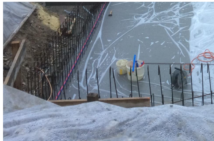
Fugen abdichten, Beton abdecken
