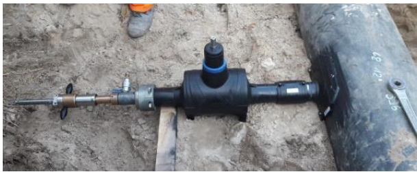
Grossrohrsattel – Anbohrung unter Betriebsdruck
