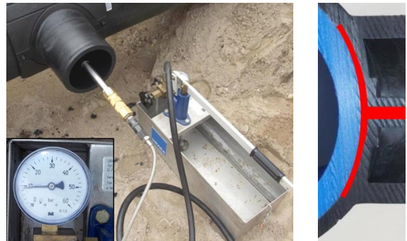
Druckprüfung vor dem Anbohren über den Abgang
