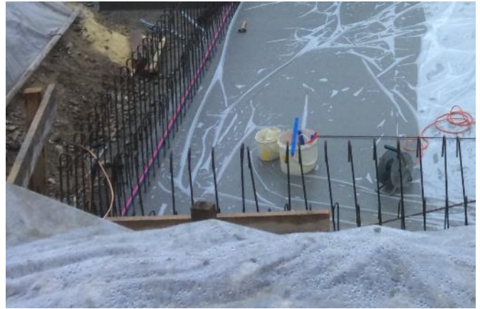
Foto 2: Abdichtung Bodenplatte-Wand
