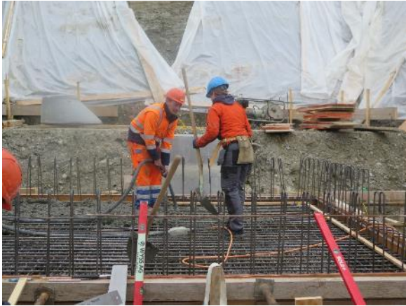
Foto 1: Bewehrte Bodenplatte
