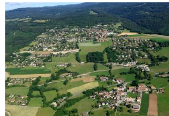
Abbildung 12: Luftaufnahme der Waadtländer Gemeinde Arzier - Le Muids am Jurahang. (Quelle: Gemeindeverwaltung Arzier - Le Muids)
