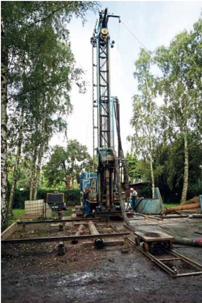
Studienreise Hamburg: Brunnenbaustelle Tiefenbohrung
