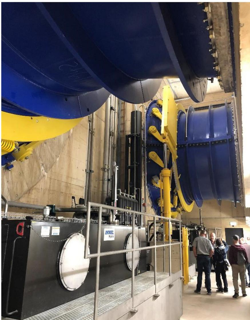
Im Inneren die zwei im Durchmesser von 4,4 Meter grossen Turbinen. Hier sichtbar, die grossen Leitapparate, welche die Durchflussmenge regulieren.
